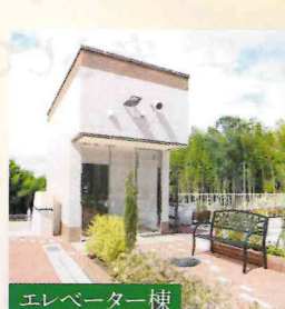
エレベーター棟
